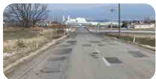
古山幹線改修予定場所
