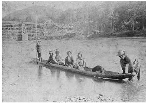
▲鉄橋手前側が紅葉山方面、鉄橋奥が川端（栗山側から撮影している）
