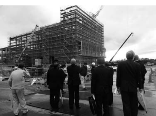
焼却施設建設の様子
