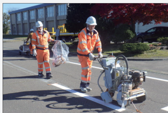
△由仁小学校敷地内区画線補修
