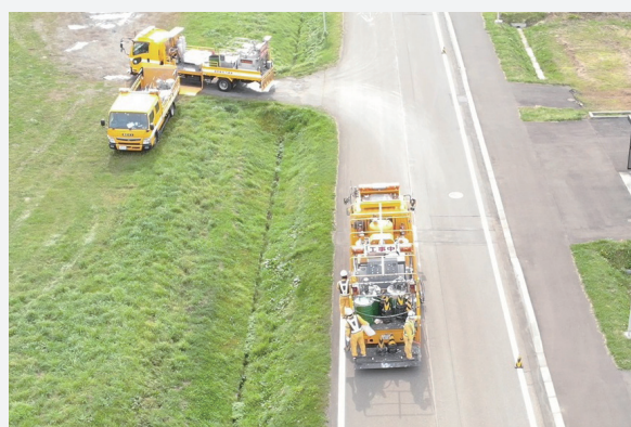
△町道歩道・中央線等白線引き
