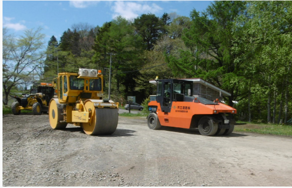
▲伏見台公園駐車場砂利敷整地補修
