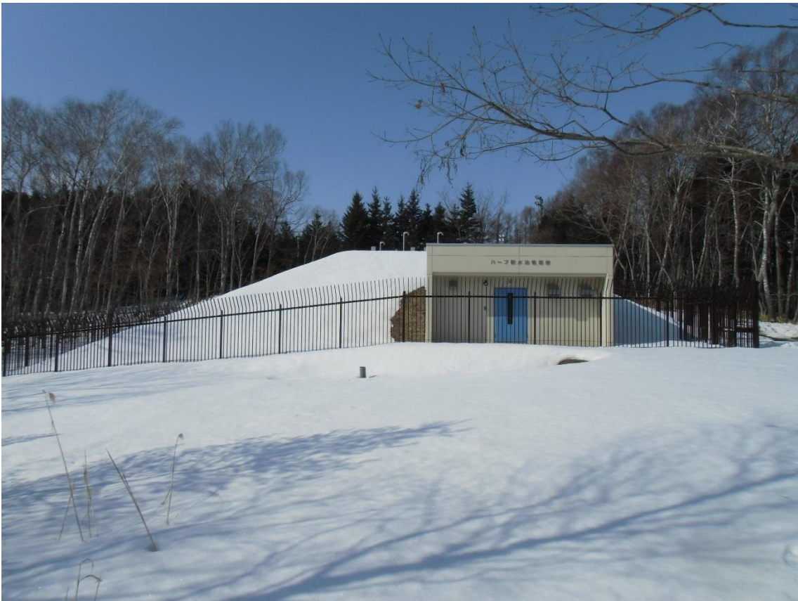
(ハーブ配水池)
